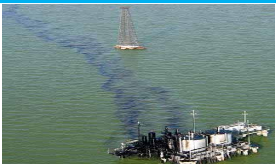
Pozo y plataforma petrolífera sufriendo un derrame habitual
