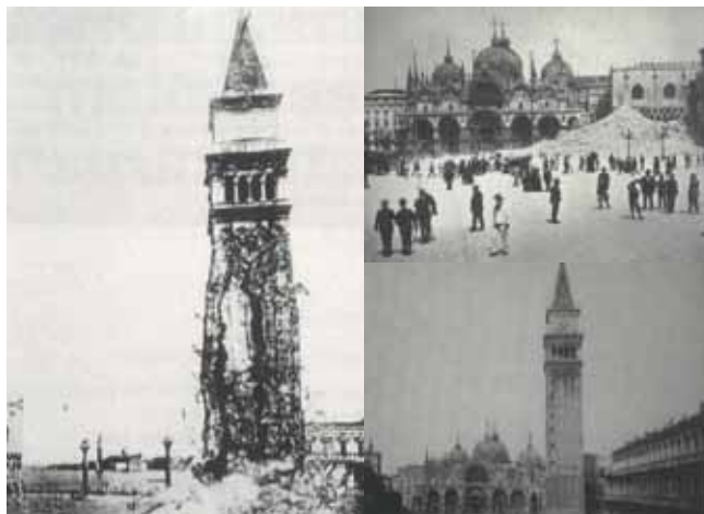
Fig. 9. San Marcos Venezia, colapso y restos del Campanile
