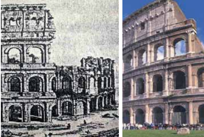
Fig. 10. El Coliseo antes y después de su intervención
