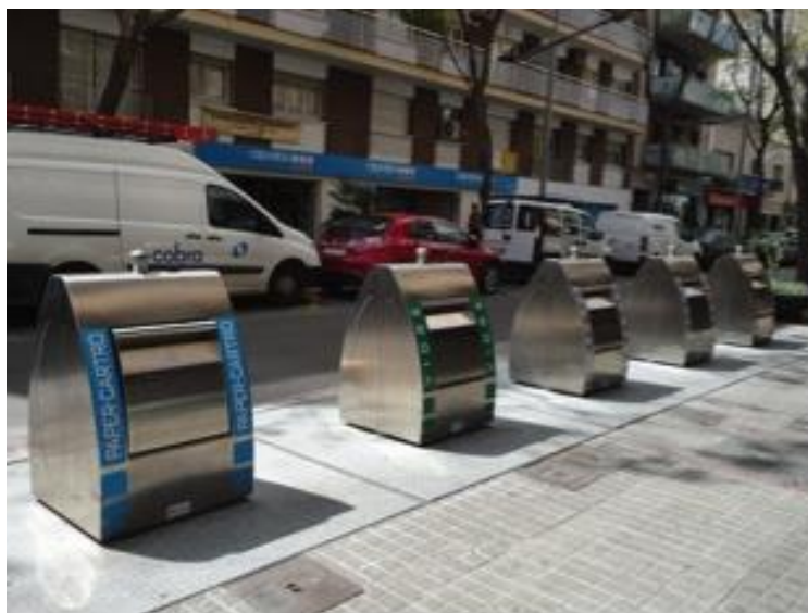
Fotografia 1. Containers com armazenamento subterrâneo de resíduos na cidade de Cerdanyola del Valles (Província de Barcelona)
