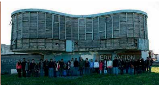
Fig. 14. El parador Ariston.
